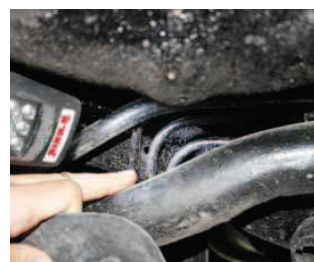
Koroze nenapadá jen karoserii, nýbrž i palivové či brzdové vedení
