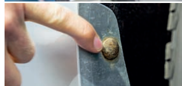
Přelakované plastové díly a koruze nepůvodních druků prozrazují řemeslně odbyté opravy a nutnost vše v budoucnu hlídat
